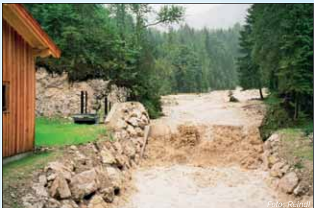
Hochwasserzeiten am Rohntalbach: Wasserfassung auf 1111 m NN.
