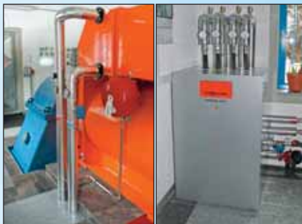
3 Grad Temperaturdifferenz reichen für die Wärmepumpe (re) aus, um den Gasthof zu heizen
